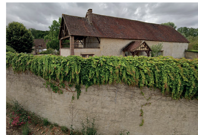
Ensemble de bâtiments en entrée sud du hameau du Mesnil-Ponceau
